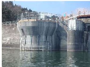
撤去した取水ゲート上屋
