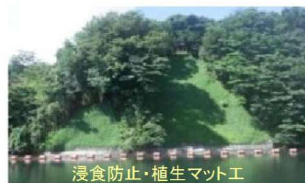
法面保護対策後の状況
