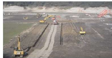
貯砂施設掘削状況
