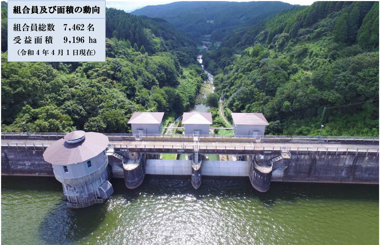
北山ダム堤体上空からの様子
