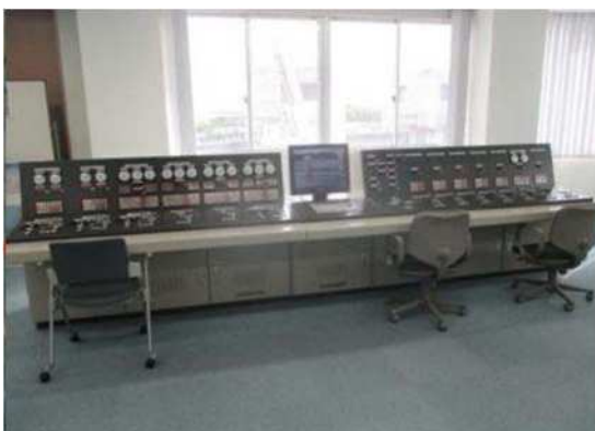
水管理施設（川上頭首工中央管理所）
