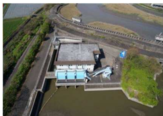
排水機場（佐賀市城西機場）
