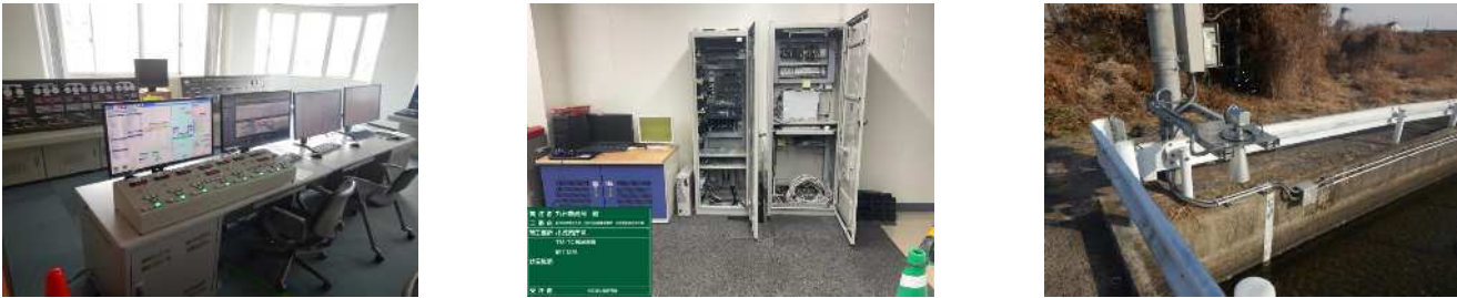
川上頭首工操作室 (奥側：旧システム、手前：新システム) 小城市庁舎内 (システム制御盤の更新作業状況) 上飯盛子局 (水位計更新後)
