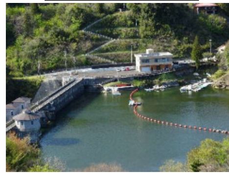
水管理施設・管理棟更新
