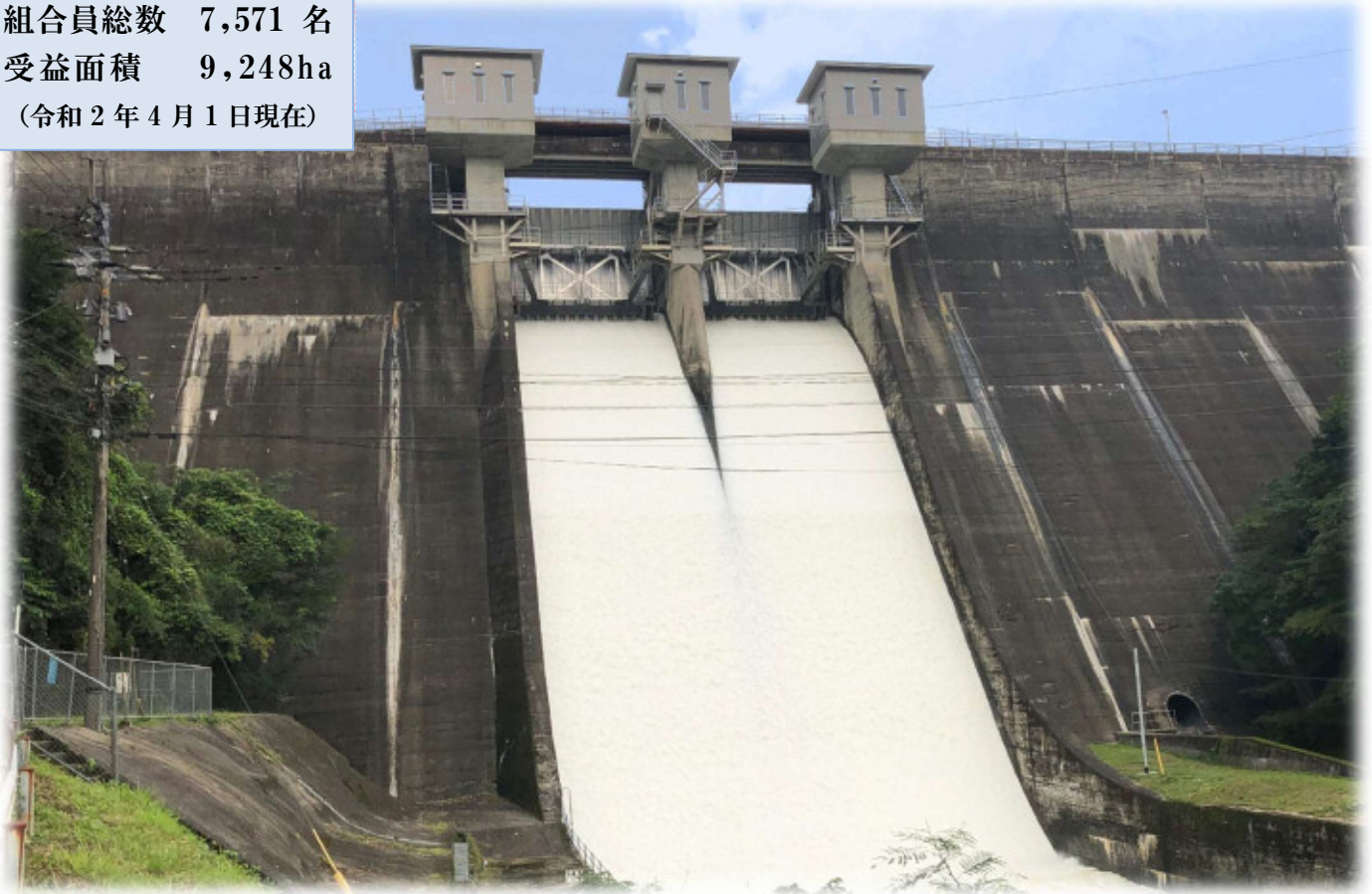
農地防災事業で改修された北山ダム(放流中)
